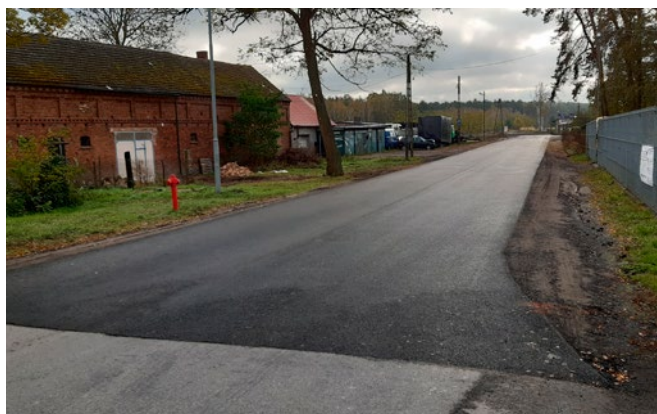
Rys. 4. Ułożona warstwa ścieralna (zamykająca) z mieszanki mineralno-asfaltowej na warstwie nośnej z pianobetonu
