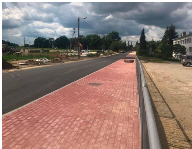
Droga powiatowa, ul. Celna w Myśliborzu
