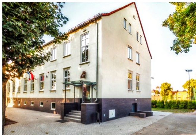
Remont budynku Zespołu Szkół i Placówek Oświatowych w Mysliborzu
