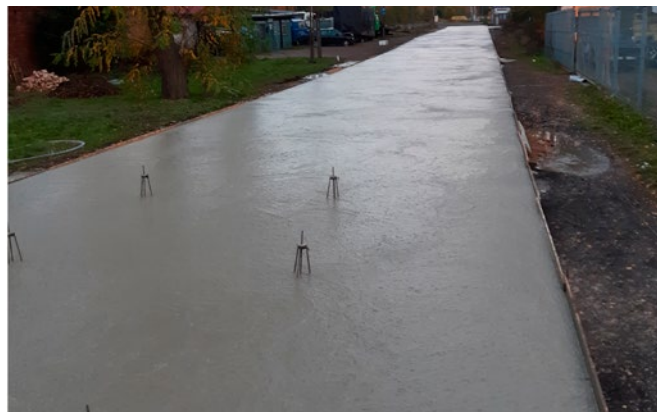
Rys. 3. Warstwa nośna konstrukcji nawierzchni drogowej z pianobetonu
